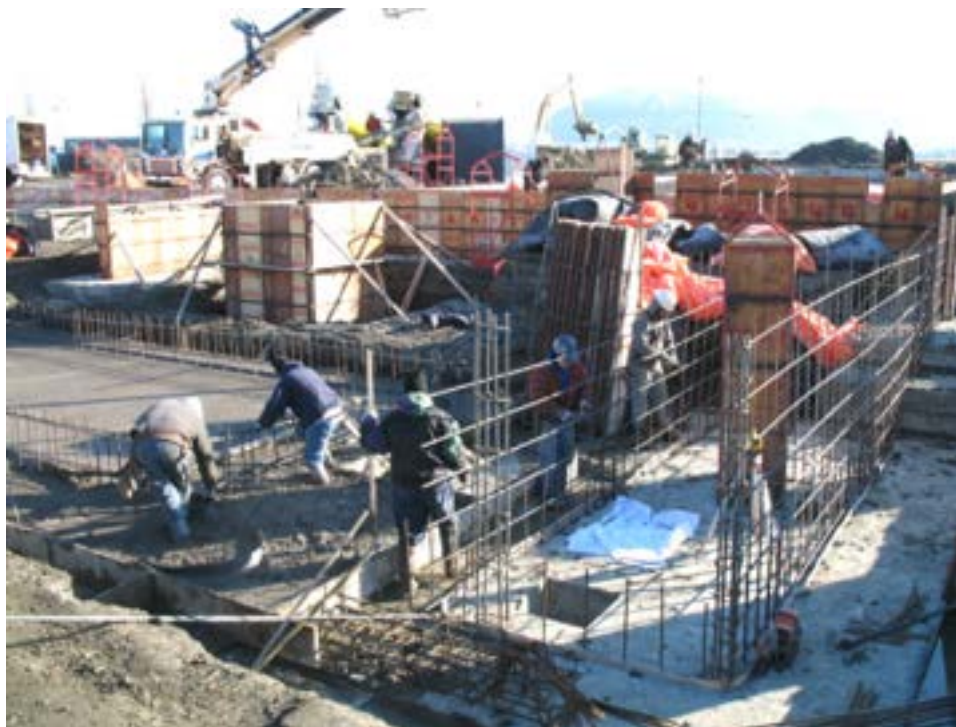
Fondations du bâtiment du CÉROM : coffrage, armature et coulée de béton réalisés sous des conditions météo exceptionnellement clémentes, le 12 décembre 2006.
